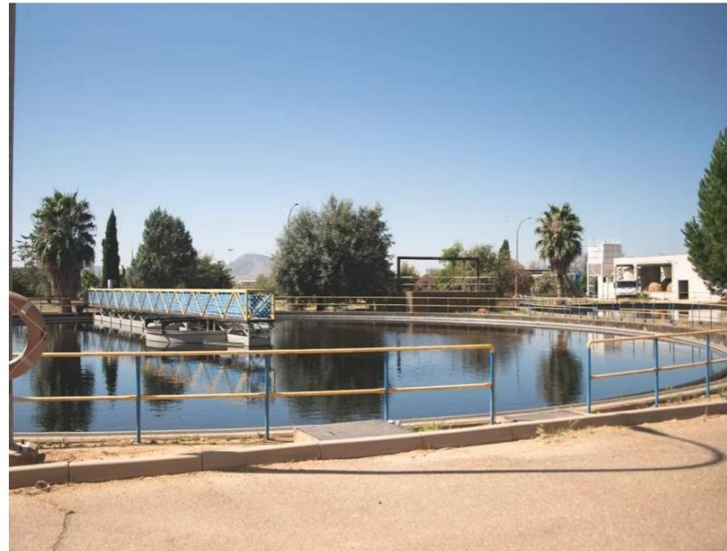
Depuradora de Mérida Canal Extremadura
